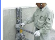
支柱付スライドブロック 本体の取付
