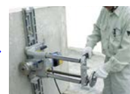
支柱ブラケット部の取付
