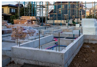
電気・空調・ガス・水道配管の穴あけ
